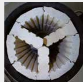
Blick von oben in die Y-förmigen Sturz- und Steigzüge des Schamottespeichers
